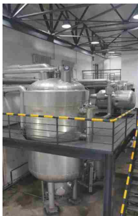
气载源项行为特性综合 实验装置
